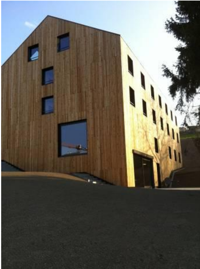
Nord- und Westfassade
